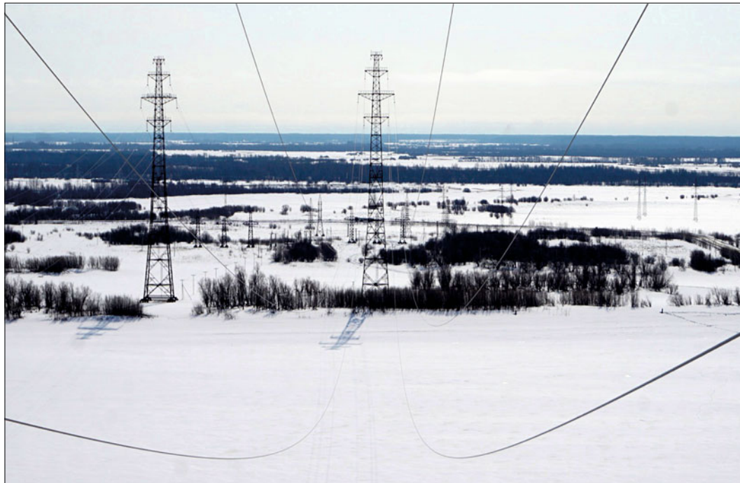
Рис. 8. Переход ВЛ 110 кВ Куделинская – Шубинская и Росляковская – Приобская – Шубинская через р. Обь
