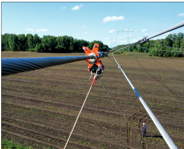
Рис. 4. Перемещение измерительной головки вдоль провода с помощью капронового каната
