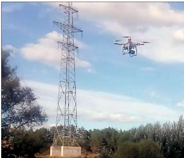
Рис. 1. Визуальный контроль состояния проводов ВЛ 35 кВ при помощи беспилотного летательного аппарата с устройством видеofиксации
